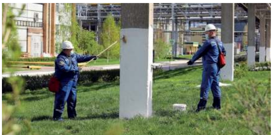
Побелка эстакад – важная часть субботников. На фото – персонал цеха централизованного ремонта и оборудования (№27).
